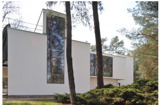
Dessau, Haus Kandinsky-Klee, Nordansicht nach der Sanierung (Bild: © Brenne Architekten )
