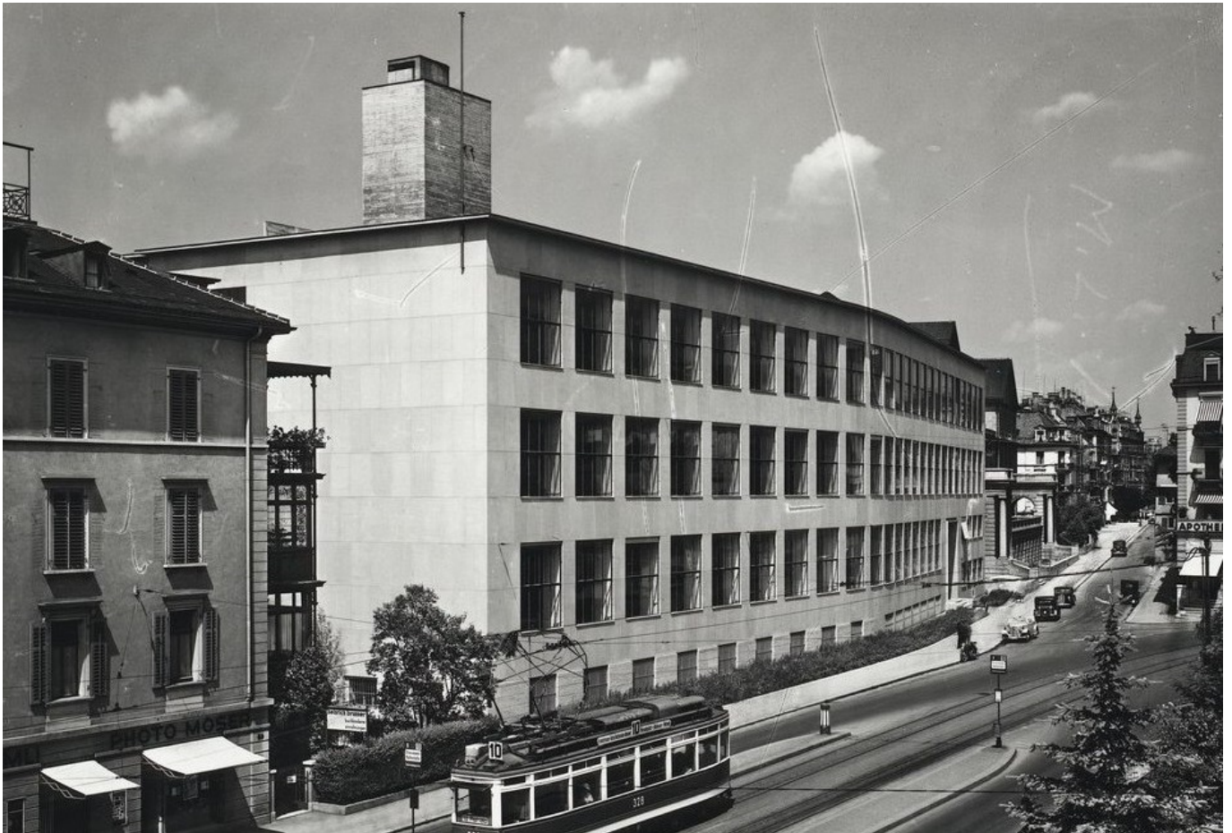
Zürich, Maschinenlaboratorium, Straßenfassade des Lehrgebäudes zur Sonneggstraße, um 1934 (Bild: ETH Bibliothek, Zürich, PD)
