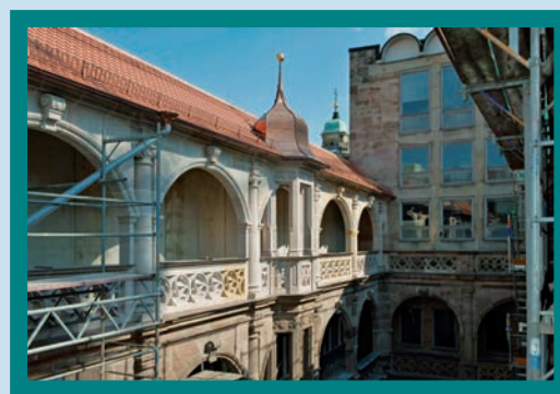
Zeitschichten: Der Nürnberger Pellerhof Richtung Süden mit historischem Bestand, Neubau der 1950er Jahre und rekonstruierten Bauteilen. Foto: Uwe Kabelitz
