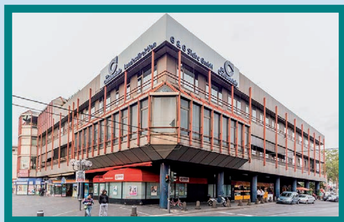
Stadtbildprägend? Wohn- und Geschäftshaus vor dem Hauptbahnhof in Bonn. Foto: © Eckhard Henkel (CC BY-SA 3.0 DE via Wikimedia Commons)
